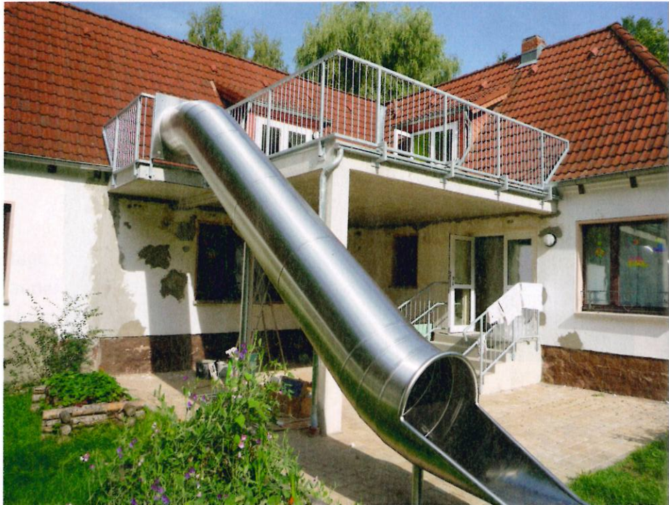
Abb. 4: Ausgang zu einer Evakuierungsrutsche im Obergeschoss einer Kita
