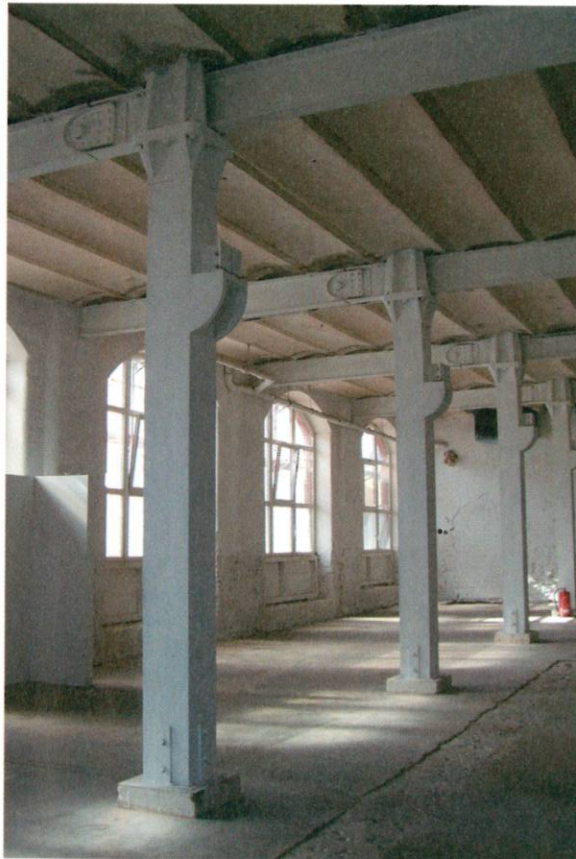
Dämmschichtbildender Brandschutzanstrich auf Gusseisenstützen und Stahlträgern in der Hamburger Speicherstadt
