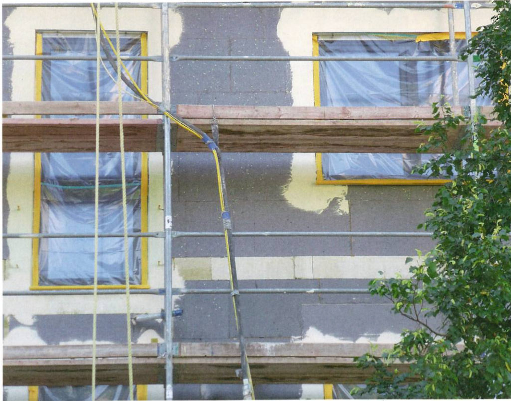
1 Moderne Gebäude erhalten häufig ein schwerentflammbares Wärmedämm-Verbundsystem.
