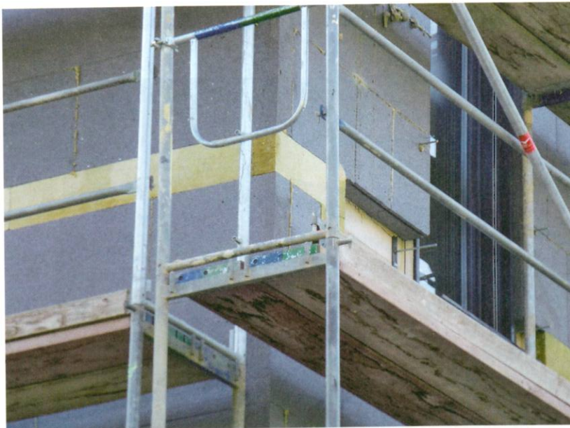
4 Etwa mittig ist der Brandriegel für das EPS-Wärmedämm-Verbundsystem zu sehen. (Fotos 1 + 4: Geburtig)
