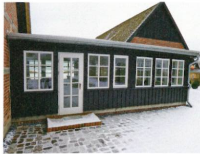
4 Schwerentflammbar nachgerüstete Holzschalung.
