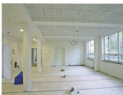
3 Nachgerüstete Stahlstützen (links).
