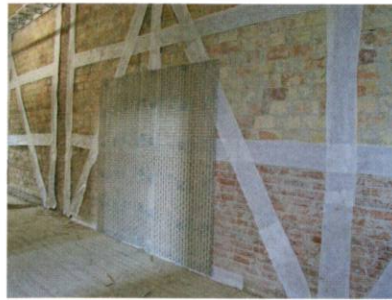
5 Bestandswand, vorbereitet mit Putzträger für eine nachträgliche Putzbeschichtung.
