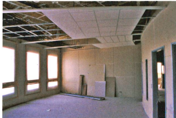
5 Nachträgliche Bekleidung von Decken und Trägern oberhalb der Unterdecke.
