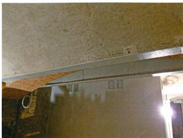
6 Dämmschichtbildender Anstrich von Stahlträgern (hier feuerhemmend).
