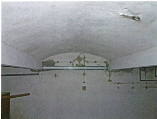
4 Brandschutztechnische Bekleidung von bestehenden Stahlträgern mit Putz.
