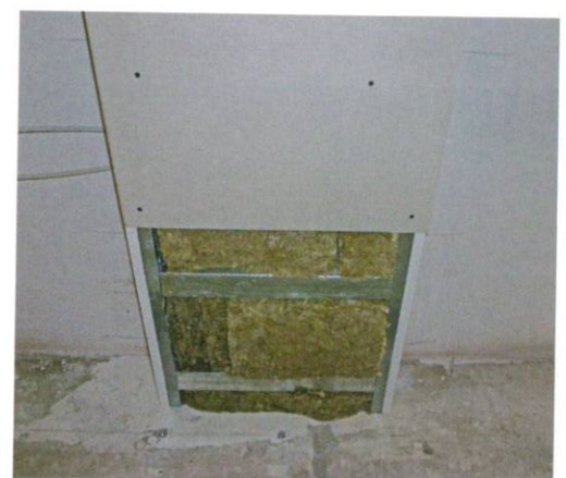
3 Brandschutztechnische Bekleidung eines Stahlträgers während der Ausführung.
