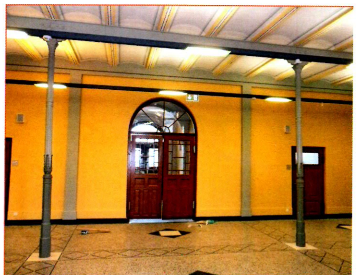
Abb. 2: Eingangshalle mit gusseisernen Stützen
