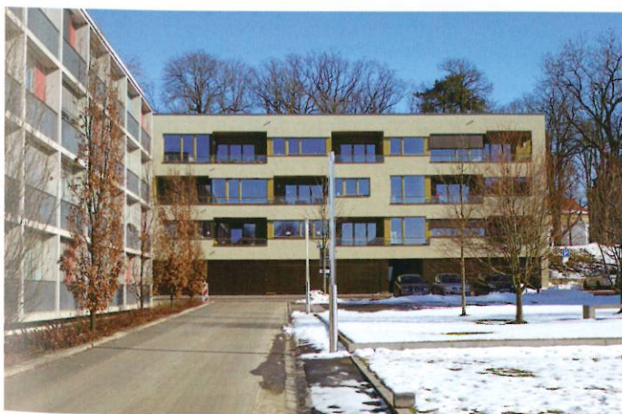
Abb. 1: Moderne Gebäude werden oftmals mit einem WDVS ausgestattet.
