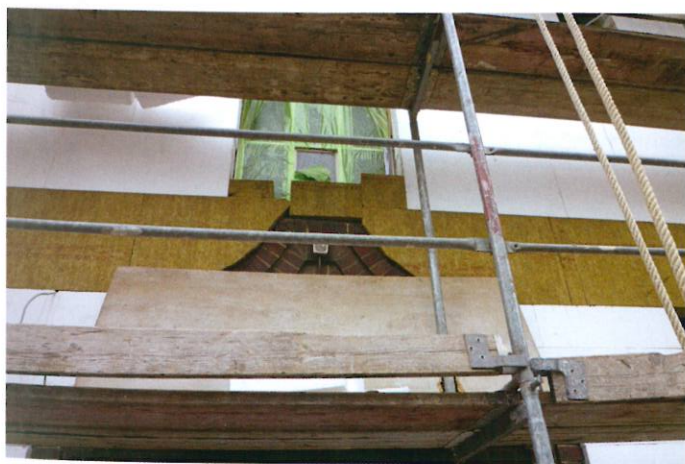
Abb. 4: Brandriegel für ein EPS-Wärmedämmverbundsystem
