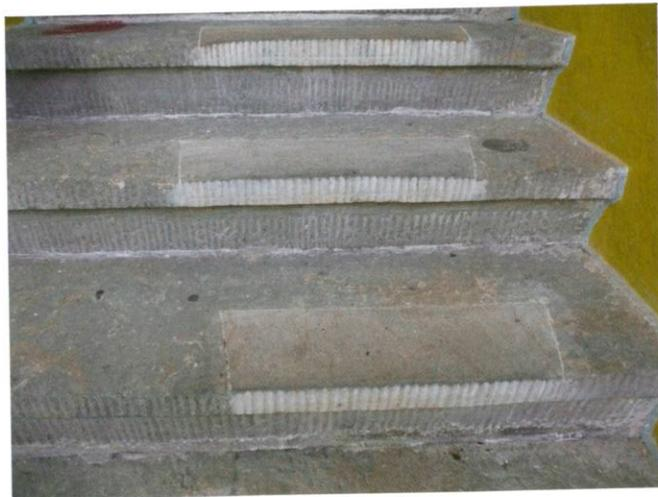
Abb. 11. Ausgebesserte Stufen eines Rettungswegs.
