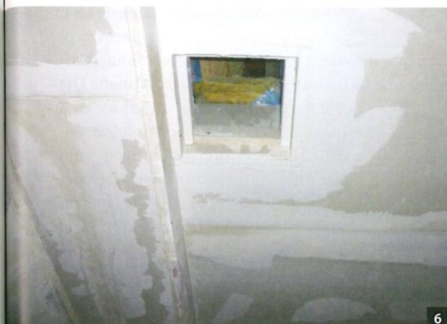
**Abb. 2:** Hier liegen die Leitungen unterhalb der brandschutztechnischen Verbesserung aus Trockenbau.
