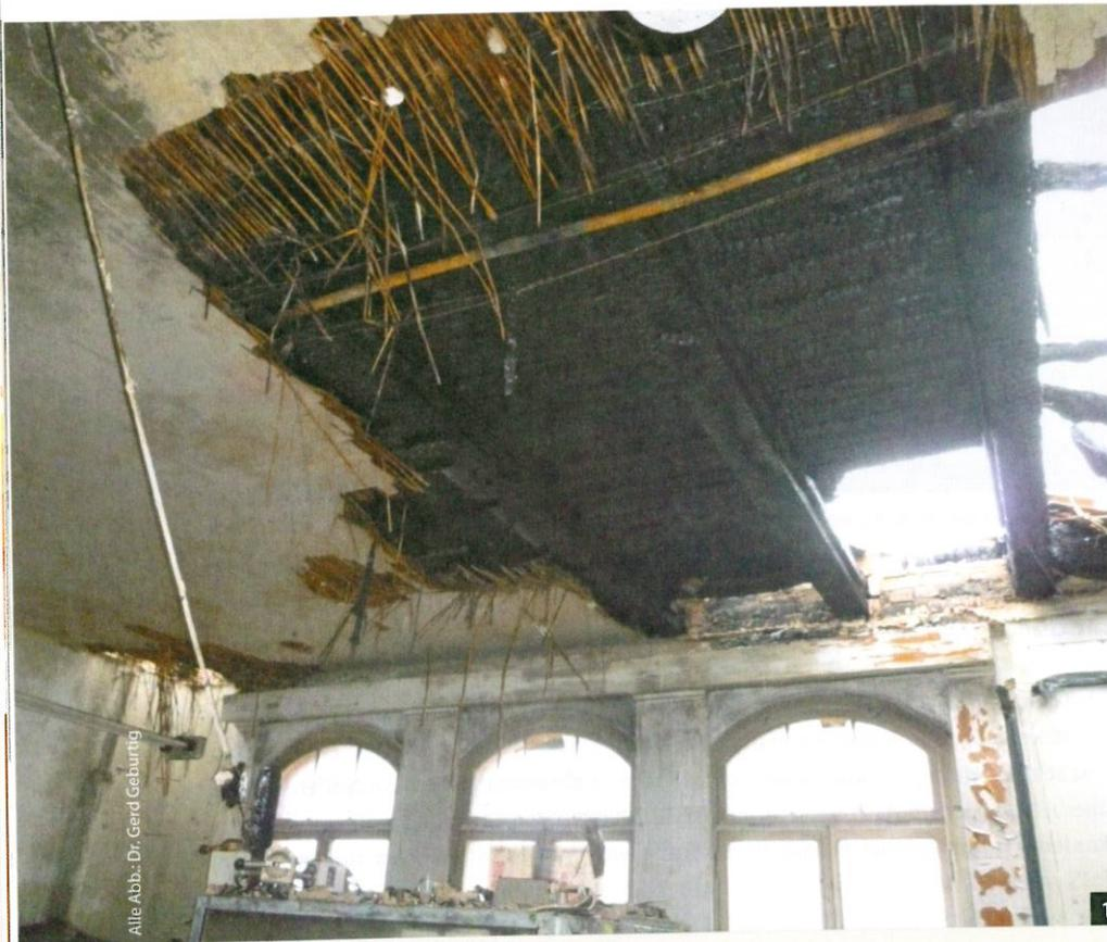
**Abb. 1:** Das Bild zeigt einen Brandschaden an einer Holzbalkendecke. Sichtbar ist, wie sich der Brand innerhalb der Konstruktion ausbreiten konnte.
