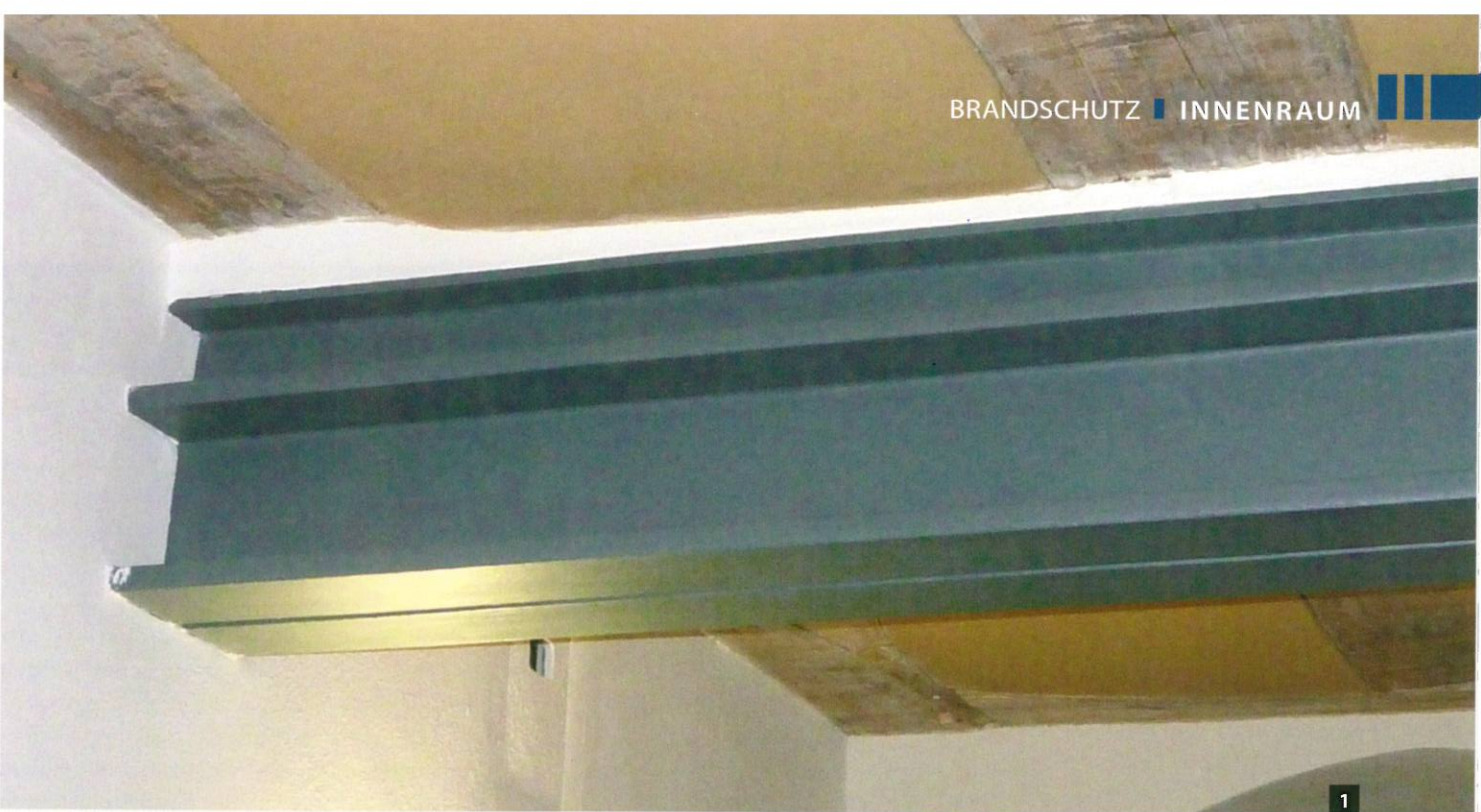
Abb. 1: Bestehende oder nachträglich eingebaute Stahlbauteile sind oftmals nachzurüsten, hier mit einem Beschichtungssystem.
