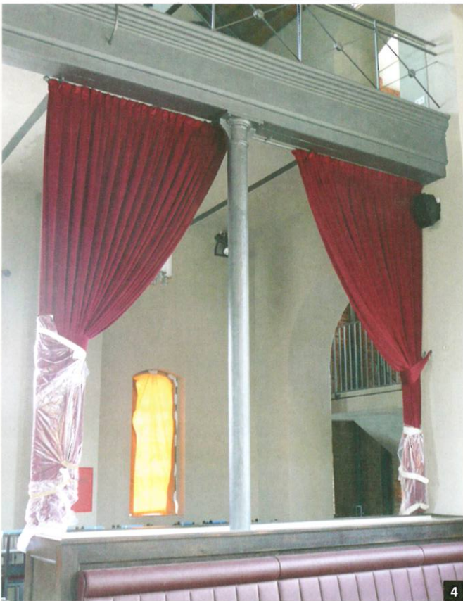
Abb. 4: Die gusseiserne Stütze konnte nachträglich beschichtet werden.
