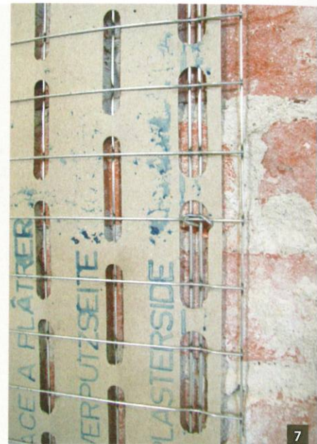
Abb. 7: Die Bestandswand wurde mit einem Putzträger für eine nachträgliche Putzbeschichtung vorbereitet.
