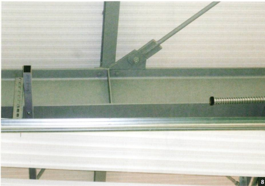
Abb. 8: Vor dem Einsatz eines Dämmschichtbildners ist die Zulässigkeit des U/A-Verhältnisses zu bestimmen.
