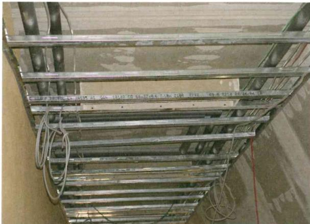
2 Vorbereitete Unterdecke unterhalb der Leitungen im Verlauf eines notwendigen Flures.
