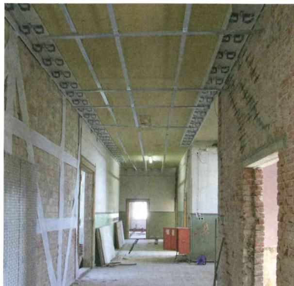
3 Installationskanäle unterhalb einer intakten Holzbalkendecke.
