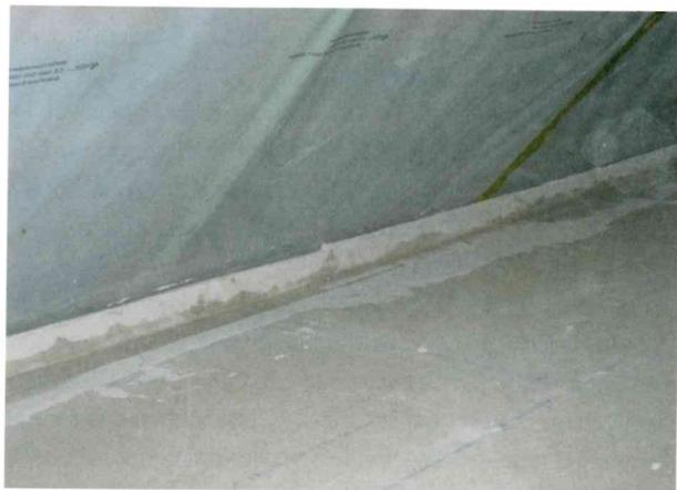
4 Regelgerechte Anschlüsse für die brandschutztechnische Deckenbekleidung von oben.
