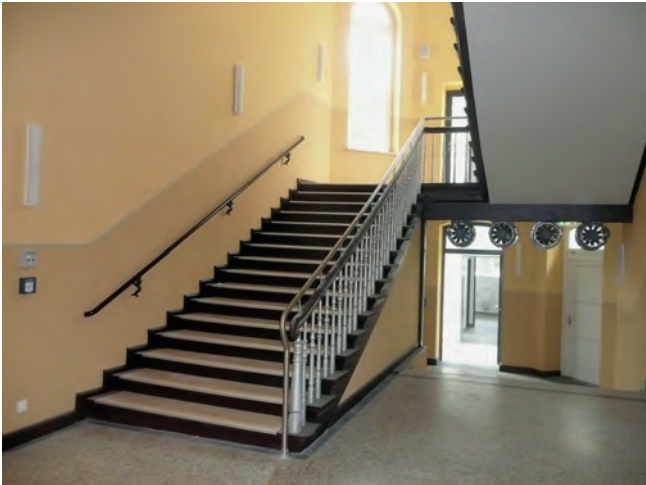
Abb. 22: Bewusst gezeigte Überdruckbelüftung in einem Treppenraum
