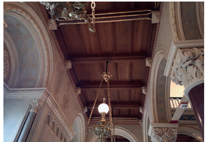
Abb. 15: Einvernehmlich nachgerüsteter Deckenbereich in einem Baudenkmal
