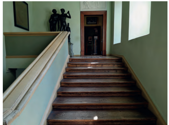
Abb. 2: Die historische Treppe im Goethehaus in Weimar verbleibt ohne Ausbildung eines notwendigen Treppenraumes im Bestand.
