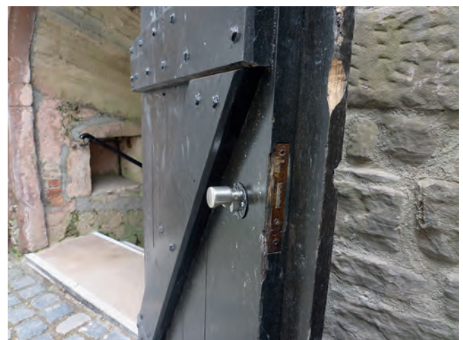
Abb. 4: Diese Bestandstür wurde mit einem Notausgangverschluss versehen, damit der Rettungsweg ausreichend sicher ist.
