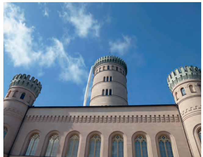
Abb. 21: Der Turm wurde mit einem Personenrettungsschlauch ausgestattet (links am Turm: zweiter Rettungsweg).
