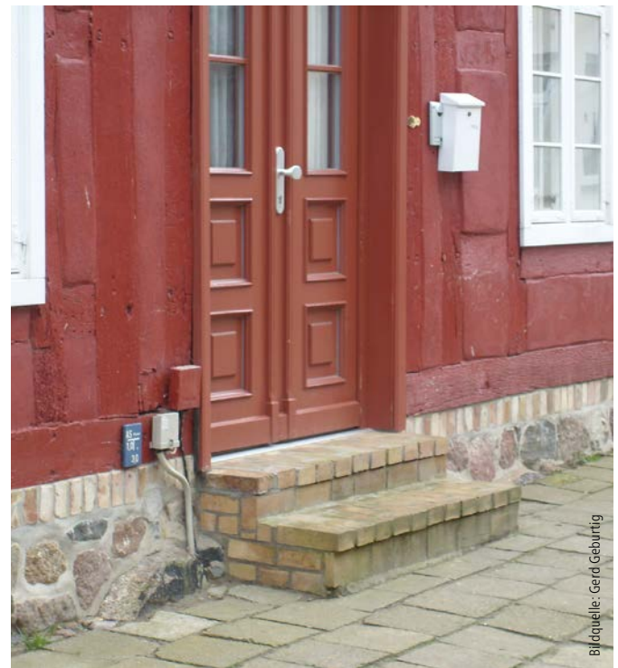
Bild 3: Empfindliche Bauteile, wie die Fußschwelle auf dem Sockel, müssen regelmäßig inspiziert werden.
