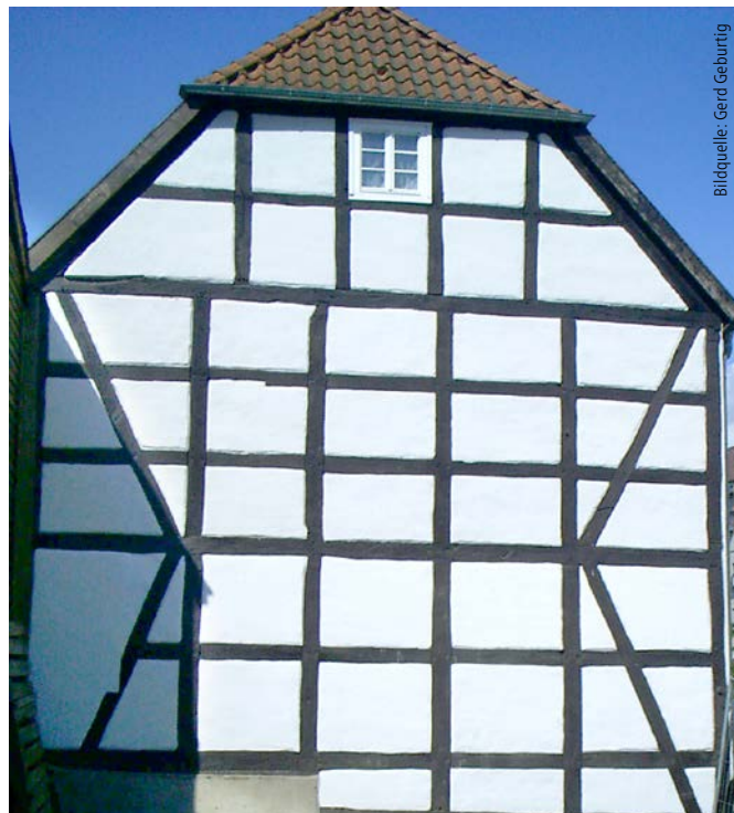
Bild 5: Hier war ein nachträglich nach einer Sanierung freigelegter Fachwerkgiebel zu überprüfen.
