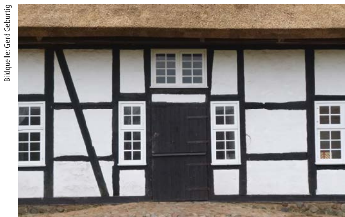
Bild 6: Dieser Fachwerkbau wird gepflegt.
