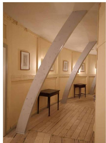
Abb. 7: Die sichtbare Bogen-Bohlen-Konstruktion im 1. Obergeschoss
