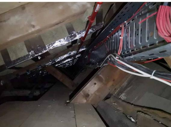
Abb. 16: Mit Mineralfaserplatten verstärkte Dachsparren
