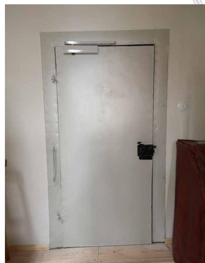
Abb. 14: Sanierter historischer Feuerschutzabschluss
