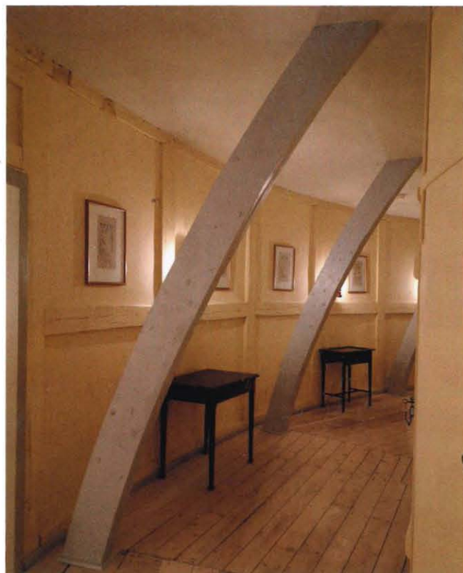
Abb. 5: Die sichtbare Bogen-Bohlenkonstruktion im 1. Obergeschoss stellte die Planer vor besondere Aufgaben.
