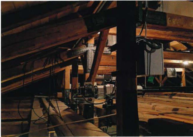
Abb. 8: Bestehendes hölzernes Tragwerk
