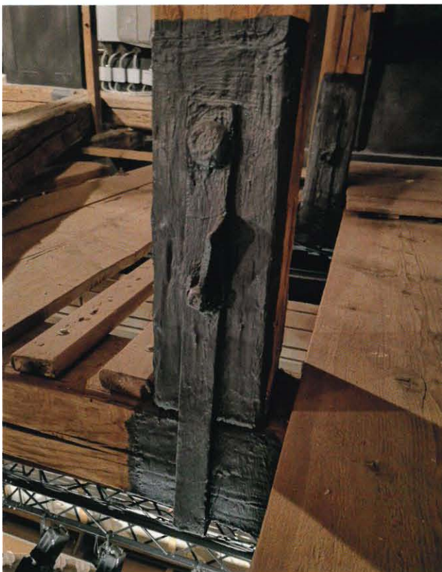
Abb. 10: Ertüchtigte Holz-Stahlverbindungen
