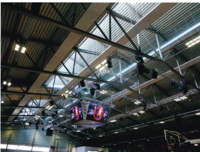
Abb. 16: Dachtragwerk ohne Brandschutzbeschichtung
