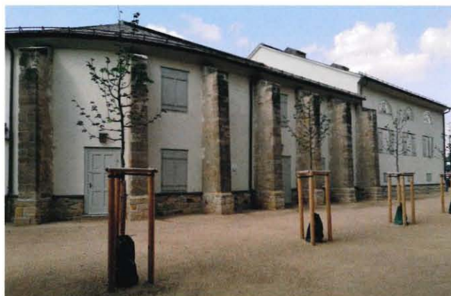
Abb. 6: Das Theater nach der Instandsetzung von außen
