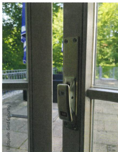
Abb. 4: Beschlag aus den 1950er-Jahren ermöglicht ein gefahrloses Verlassen der Versammlungsstätte.
