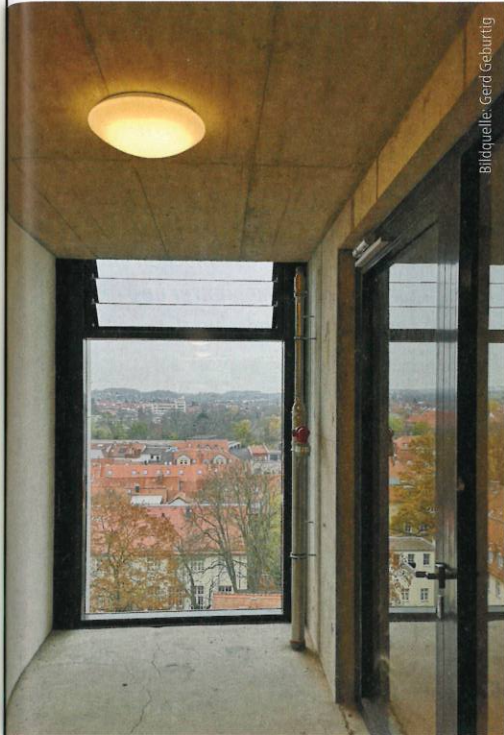
Abb. 6: Schleuse vor einem alternativen Sicherheits-treppenraum in einem Hochhaus
