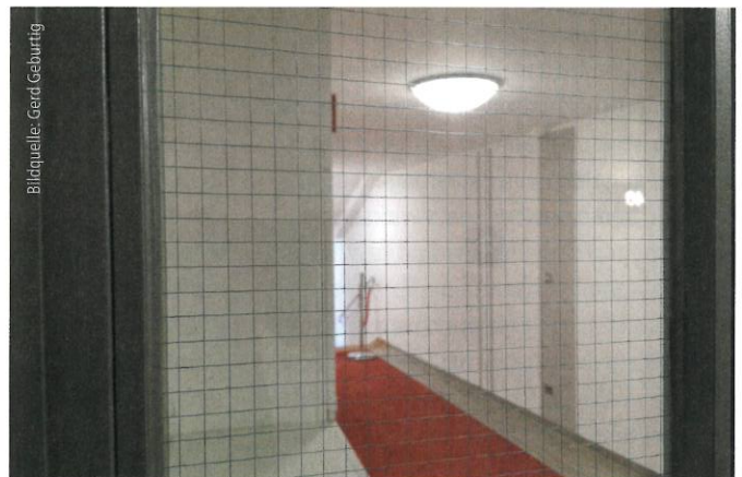
Abb. 3: Bauzeitlicher Öffnungsabschluss der 1960er-Jahre leistet weiter seinen Dienst.
