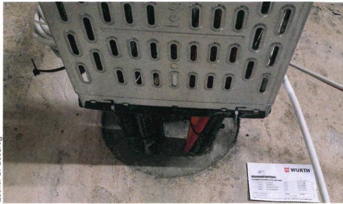
2 Einbau eines Bauproduktes in eine bestehende Stahlbetonkonstruktion
