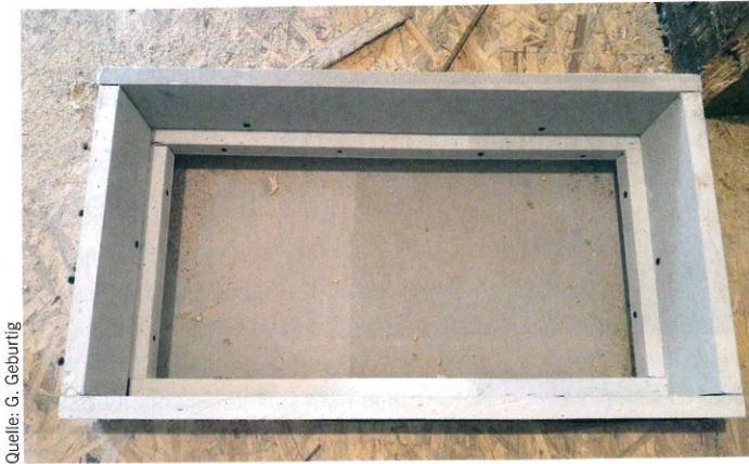
3 Auskleidung der Leibung in einer Holzbalkendecke
