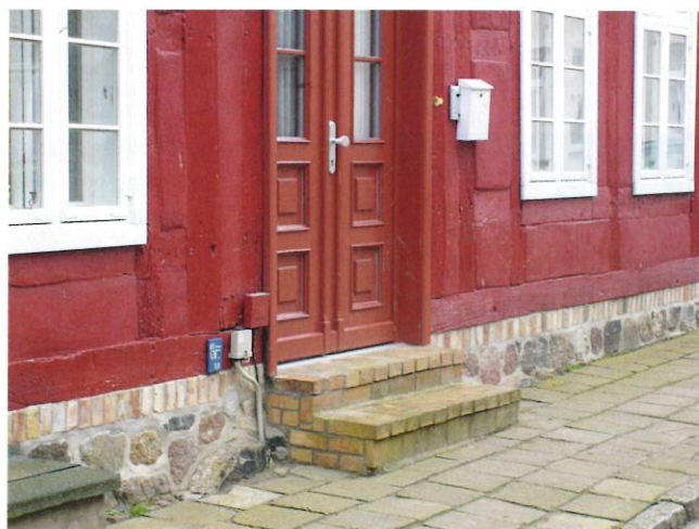
Abb. 3: Empfindliche Bauteile müssen regelmäßig inspiziert werden
