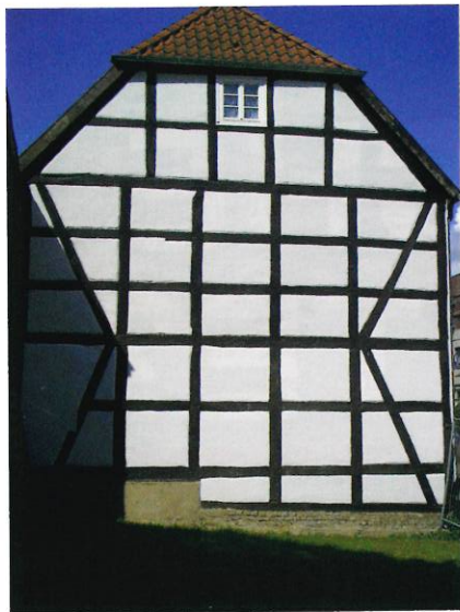
Abb. 5: Ein nachträglich nach einer Sanierung freigelegter Fachwerkgiebel war zu überprüfen
