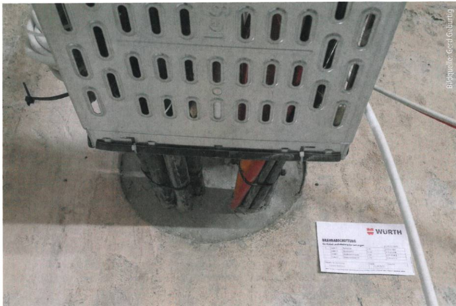
Abb. 3: Einbau eines Bauproduktes in eine bestehende Stahlbetonkonstruktion.
