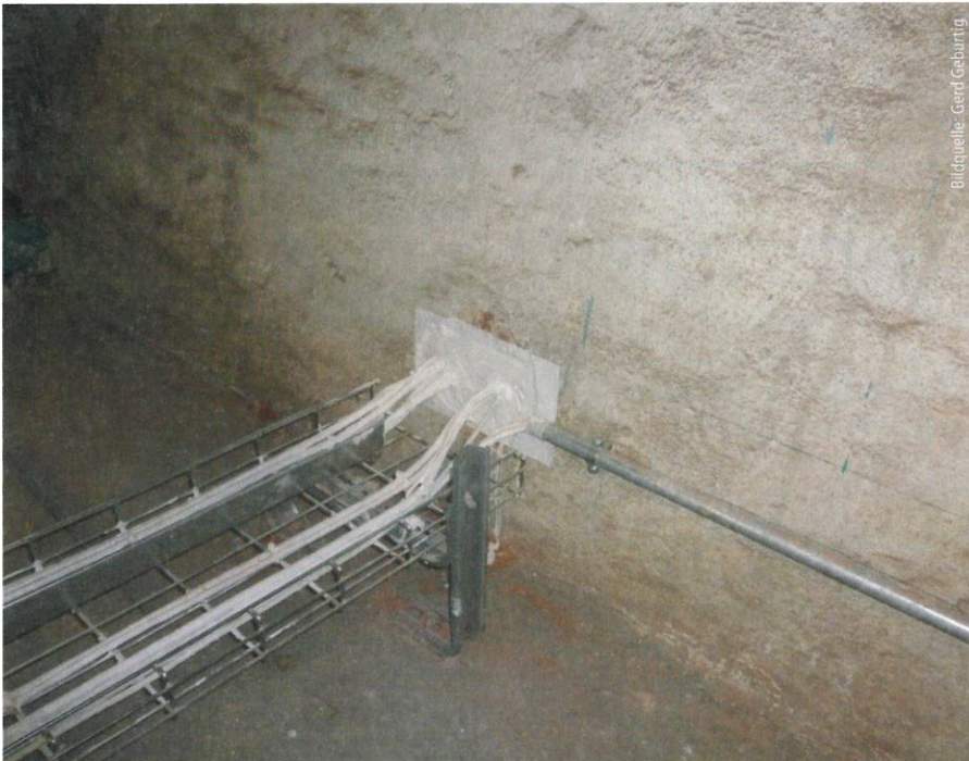
Abb. 6: Abschottung in historischem Ziegelmauerwerk
