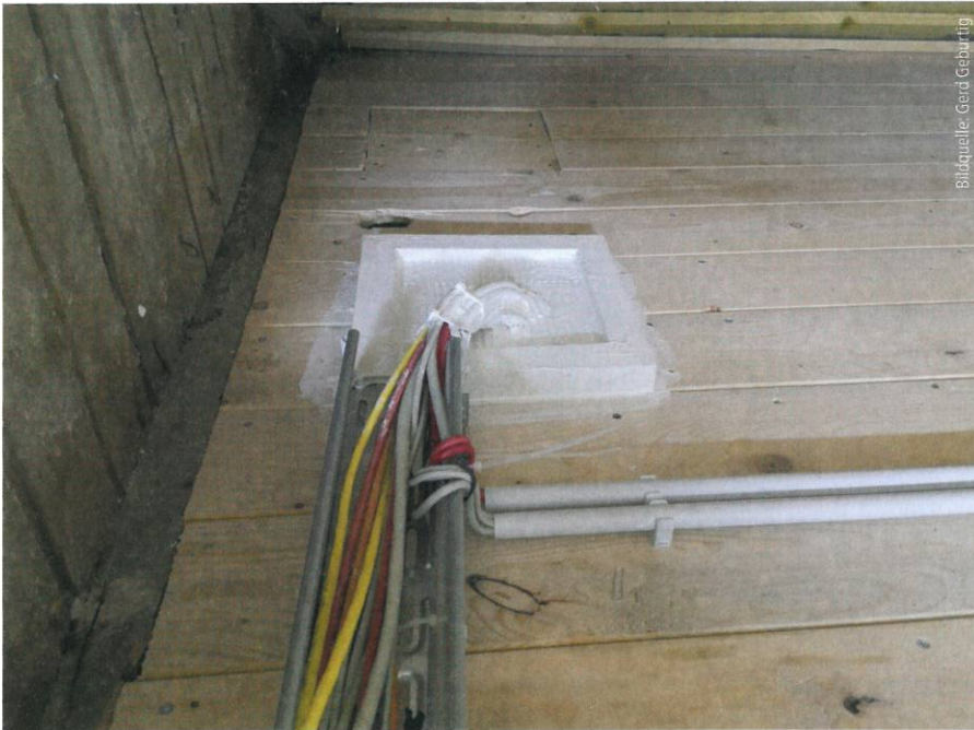
Abb. 5: Alternative Abschottung in einer Holzbalkendecke eines Baudenkmals
