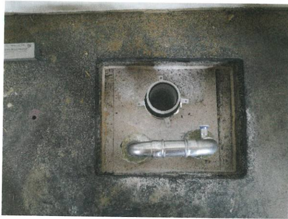
Bild 15 Einbau von Abschottungssystemen in eine bestehende Holzbalkendecke
