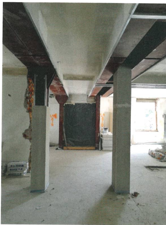
Bild 7 Massive Bestandsdecke und Stahlkonstruktion während der Ausführung
