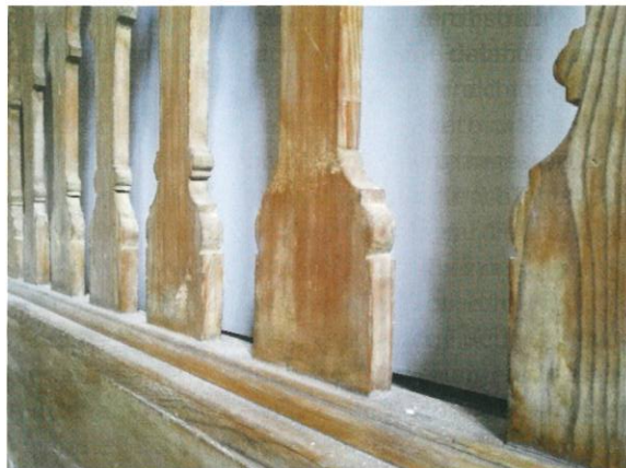
Bild 9 Anschluss der Trockenbauwand an den historischen Treppenlauf
