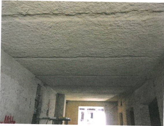
Bild 11 Ertüchtigung einer Ziegeldecke mit Brandschutzputz [16]
