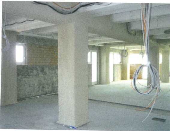
Bild 12 Brandschutzputz auf einer bestehenden Betonsäule [16]
