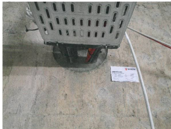
Bild 5 Einbau eines Bauprodukts in eine bestehende Stahlbetonkonstruktion
