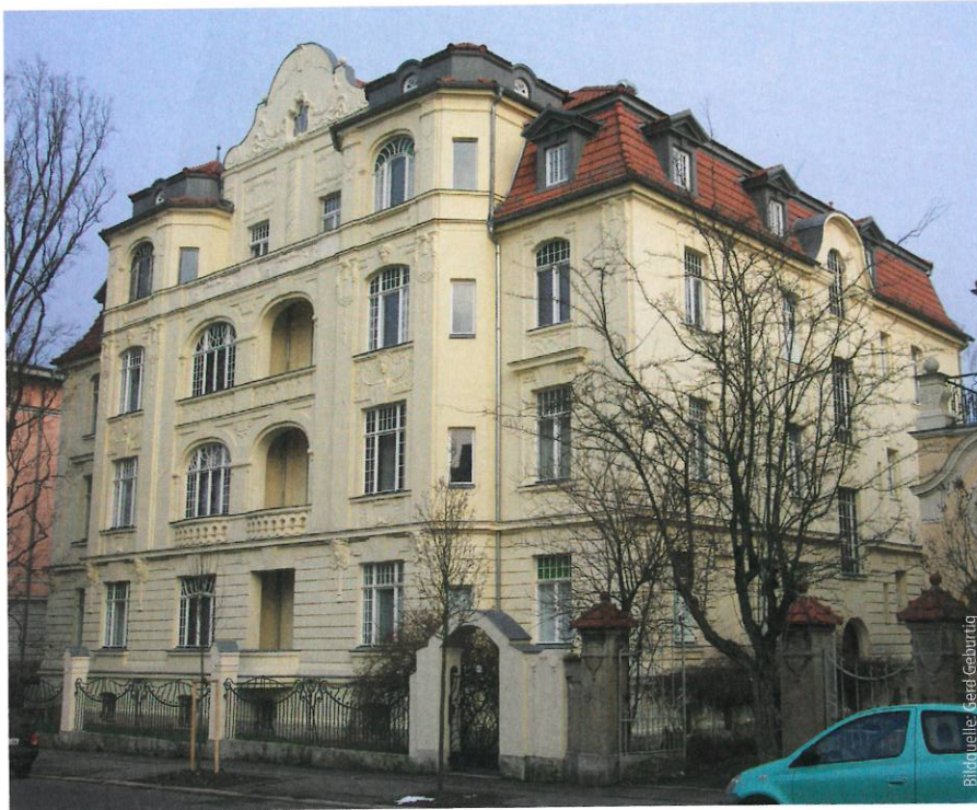
Abb. 2: 1906 errichtetes Gebäude der heutigen Gebäudeklasse 5, umgenutzt 1997
