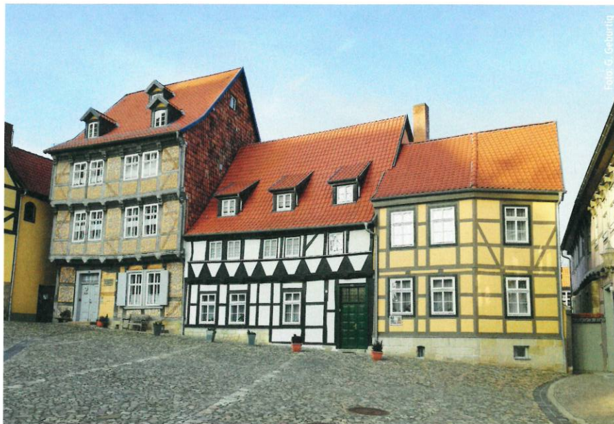
Abb. 4: Das WTA-Merkblatt 8-12 gilt weiterhin für Fachwerkgebäude.
