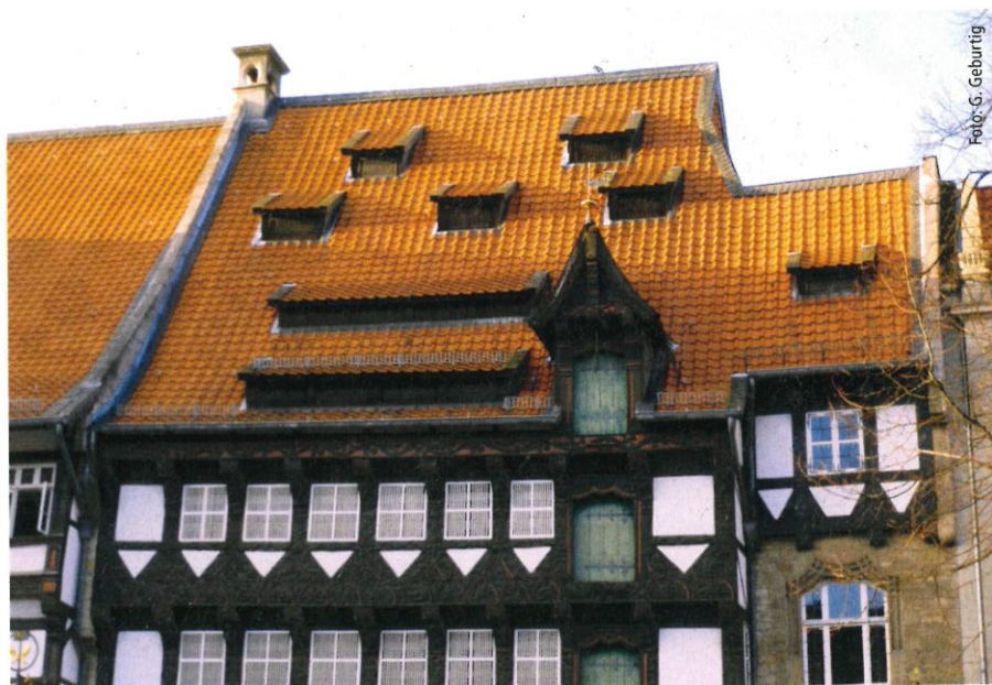
Abb. 2: Eine historische Brandmauer
