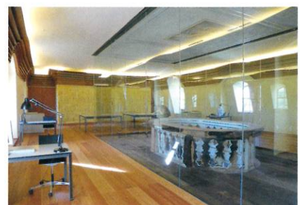
Abb. 2: Neu errichtetes Mansardgeschoss in der Herzogin-Anna-Amalia-Bibliothek Weimar, das beim Brand am 02.09.2004 beinahe vollständig verloren ging
