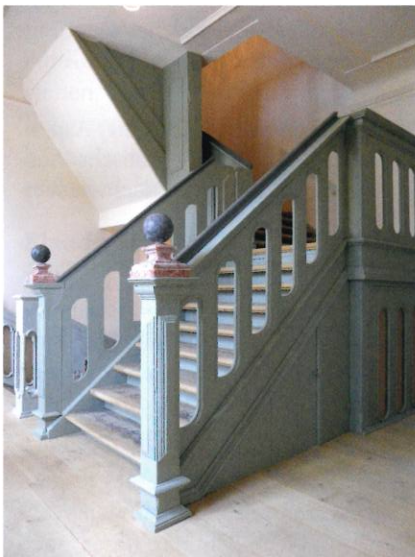
Abb. 16: Im Bestand verbliebene Holzterasse
