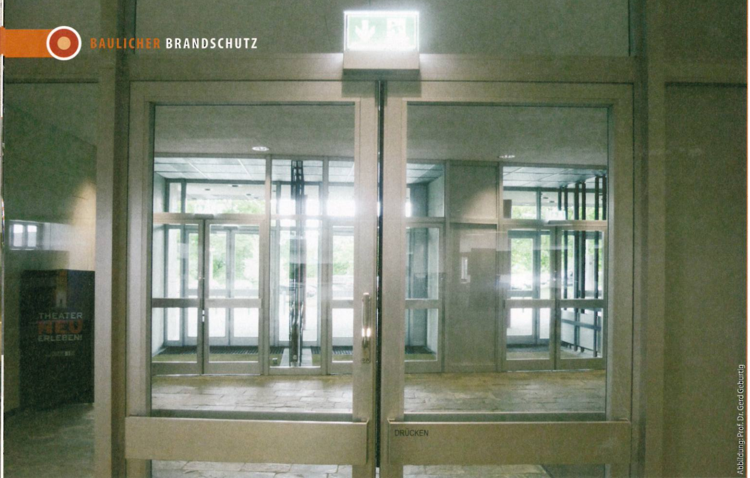
Abb. 10: Bauzeitliche Türen und Verschlüsse wurden erhalten, die Rettungswegkennzeichnung jedoch erneuert.
