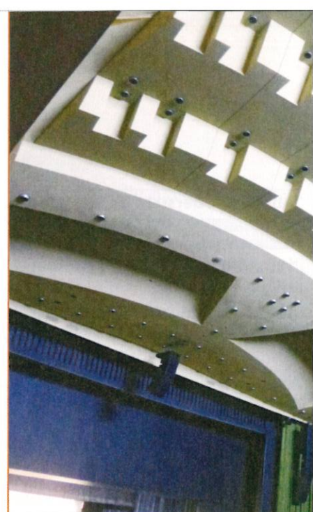
Abb. 7: Verbliebene bauzeitliche Decke und Holzbekleidungen im Großen Saal
