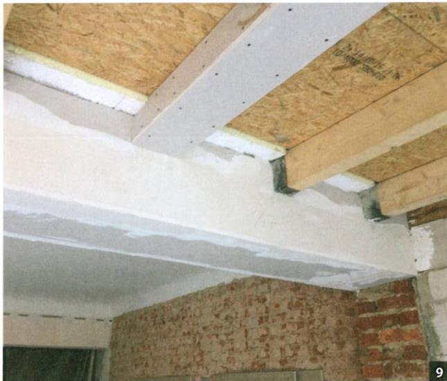
**Abb. 9:** Ist ein Einbau von Stahlträgern aus statischen Gründen notwendig, sind diese Bauteile unter Umständen gesondert zu schützen, zum Beispiel so wie hier mit einer Trockenbau-Bekleidung.
