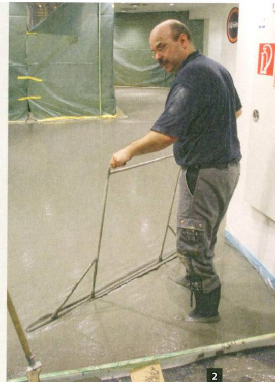
**Abb. 2:** Fließfähige Estriche und Dünnestriche werden im Stehen verarbeitet.
