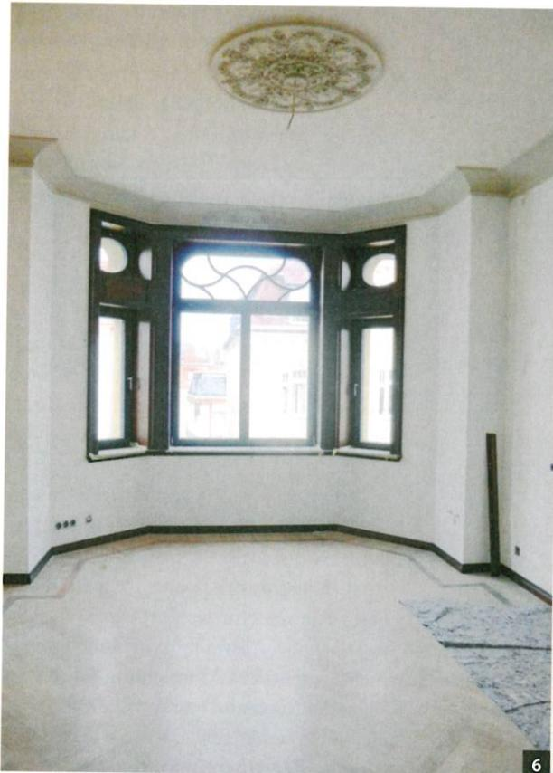
**Abb. 6:** Der Stuck wurde an eine zuvor nachgerüstete Holzbalkendecke angebracht.
