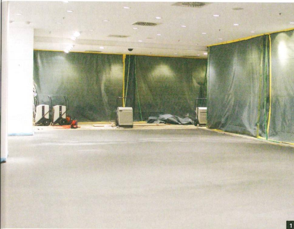
**Abb. 1:** Mit Fließestrichen lässt sich die Staubentwicklung auf der Baustelle minimieren. So können Bodensanierungen auch bei laufendem Geschäftsbetrieb ausgeführt werden.
