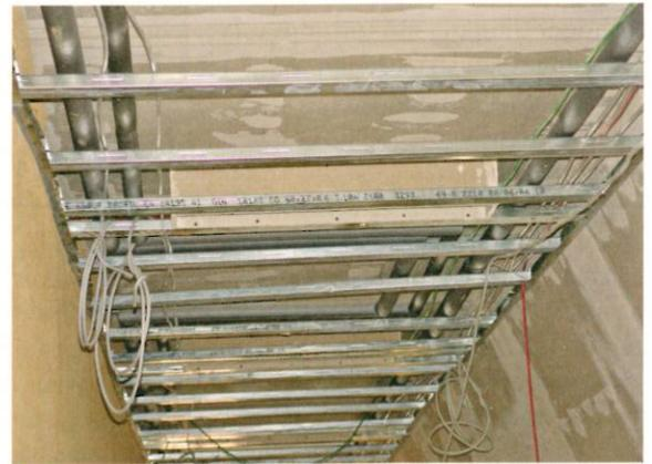
4 Vorbereitete Unterdecke unterhalb der Leitungen im Verlauf eines notwendigen Flures.
