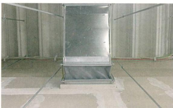
**2** Regelgerechter Einbau einer Brandschutzklappe in eine brandschutztechnisch klassifizierte Trockenbauwand vor der Spaltverfüllung.
