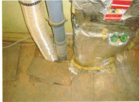
**[10]** Situation: Unsachgemäßer nachträglicher Einbau brennbarer Leitungen
