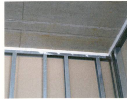
1 Exakt eingebauter Deckenanschluss.
