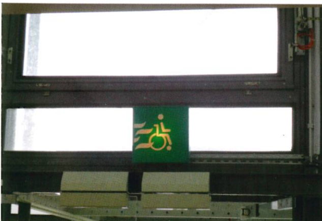
Abb. 4: Ausweisung eines barrierefreien Rettungsweges
