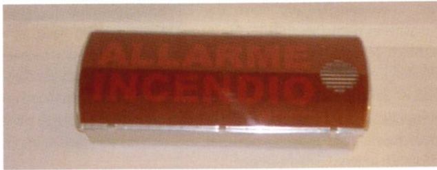
Abb. 6: Visuelle Brandalarmierung in einem Hotel
