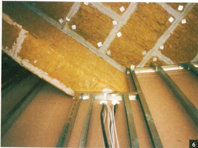
Abb. 6: Diese Stahlbetondecke wurde bekleidet und mit Abhängevorrichtungen für später anzubringende Unterdecken ausgestattet. Die hierfür benötigten kleinen Haken befinden sich teilweise an den Befestigungen.
