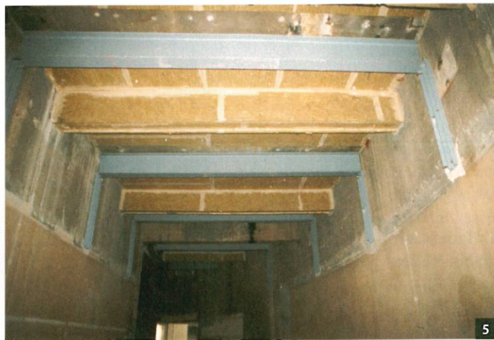
Abb. 5: Die Bestandsstahlträger und bestehende Deckenbereiche wurden bereits bekleidet. Die neu eingebauten Konsolen werden anschließend ertüchtigt.
