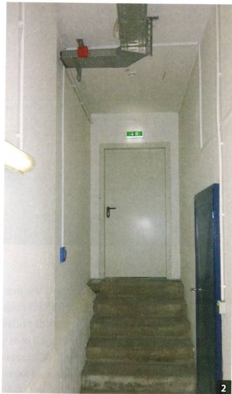
Abb. 2: Bevor eine Feuerschutztür zulassungskonform nachträglich eingebaut werden kann, müssen die konkreten Einbaubedingungen überprüft werden.
